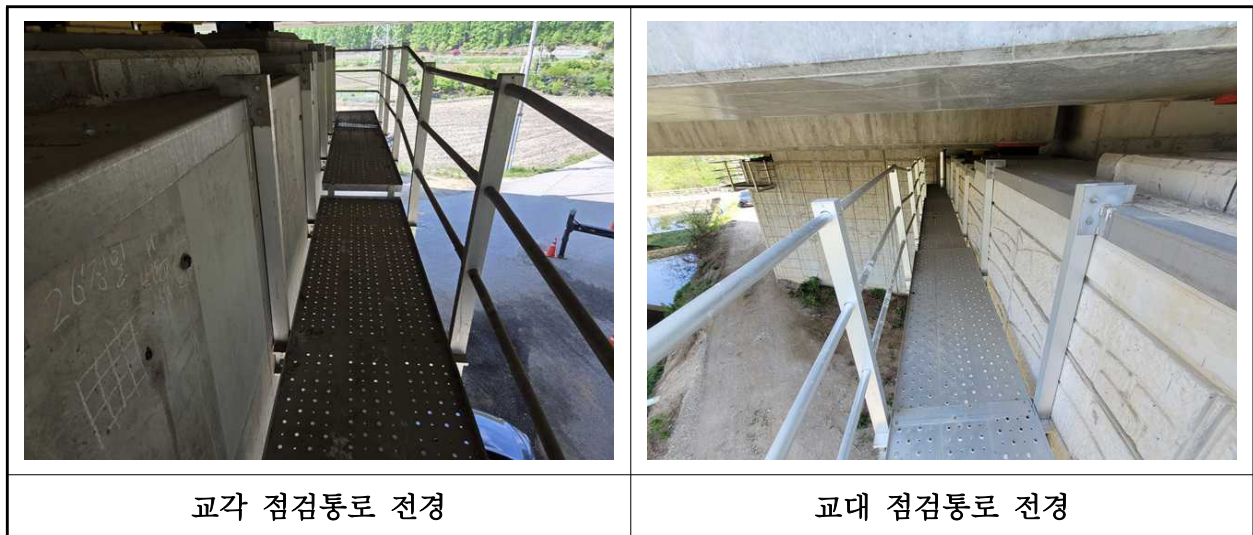
【사진 1.3.29】 교량 점검시설 전경
