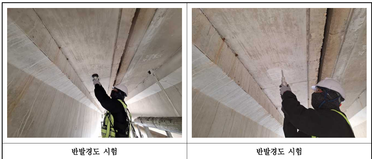
【사진 1.4.2】 반발경도시험 현장사진
