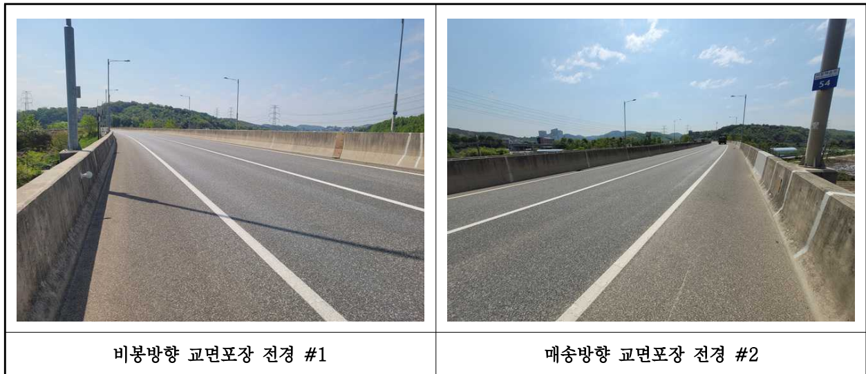
【사진 1.3.22】 교면포장 전경
