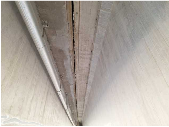
바닥판하면 S1 캔틸레버부 전경
