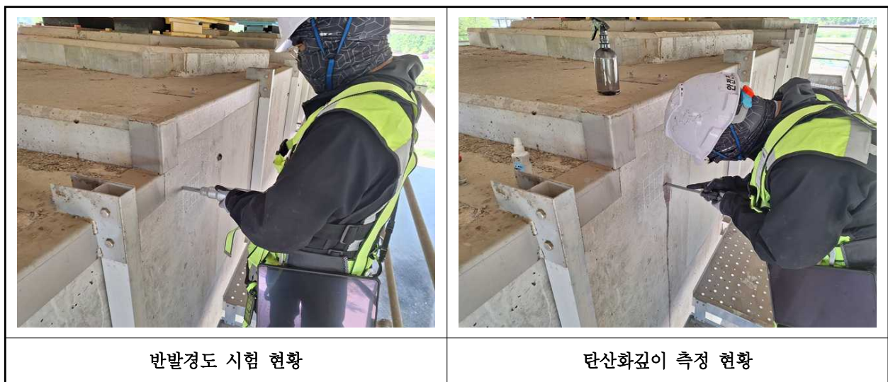
【사진 1.4.1】 콘크리트 내구성조사 현황
