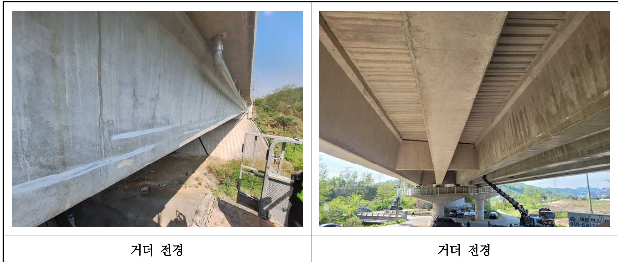
【사진 1.3.4】 거더 전경
