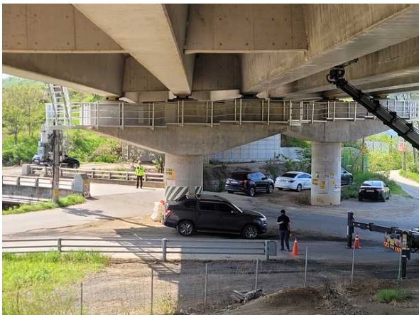
교각 P1 전경
