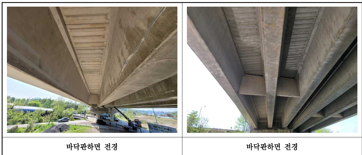
【사진 1.3.2】 바닥판하면 전경
