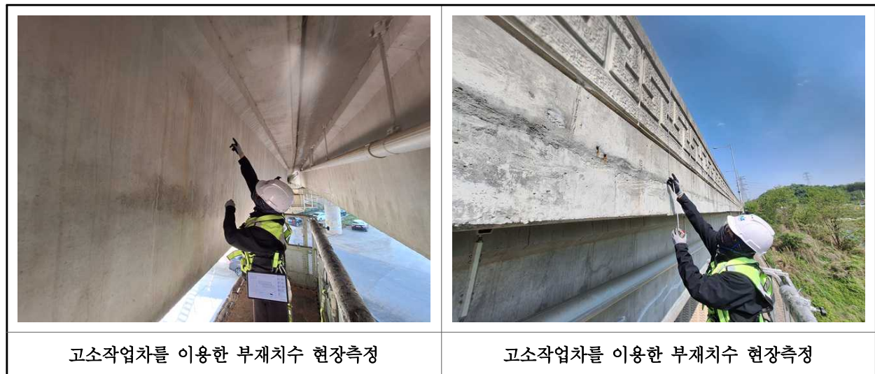
【사진 1.2.2】 부재 현장측정 전경
