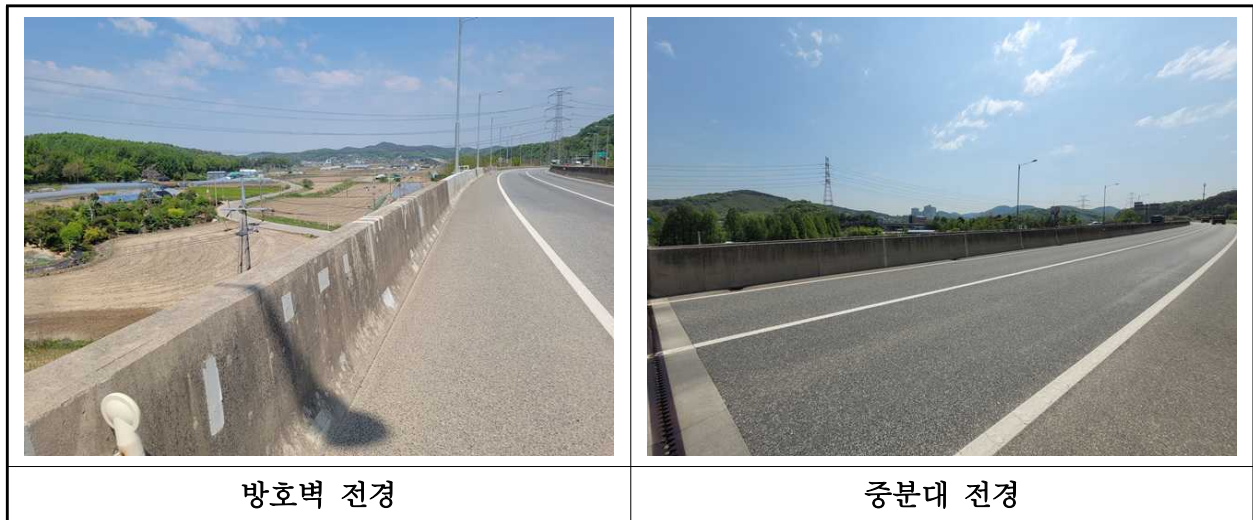
【사진 1.3.27】 방호벽 및 중분대 전경
