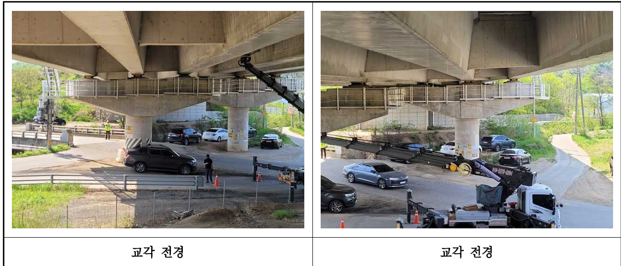
【사진 1.3.11】 교각 전경
