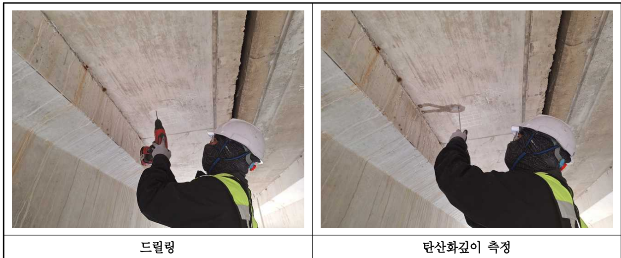
【사진 1.4.3】 탄산화 깊이 측정 현장사진
