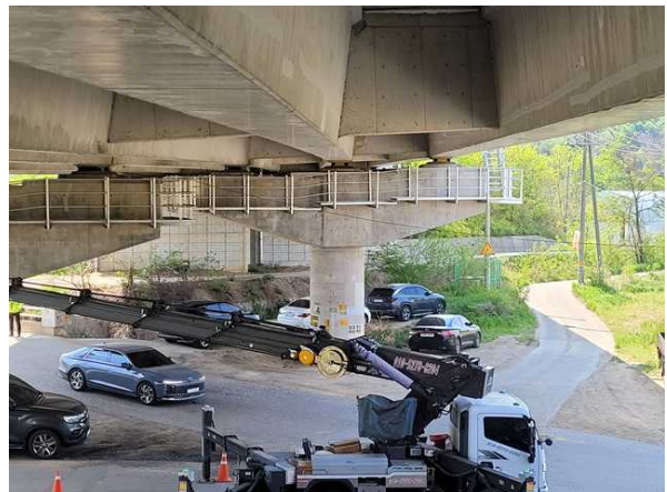
교각 P1 전경
