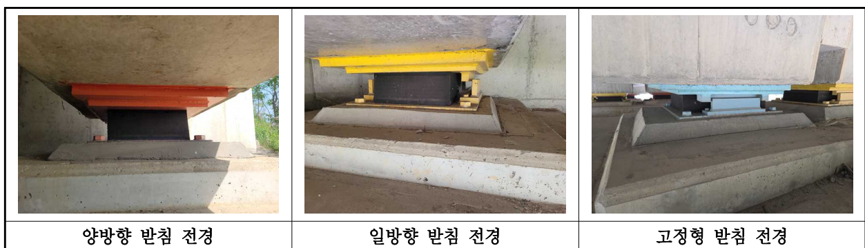
【사진 1.3.15】 교량받침 전경
