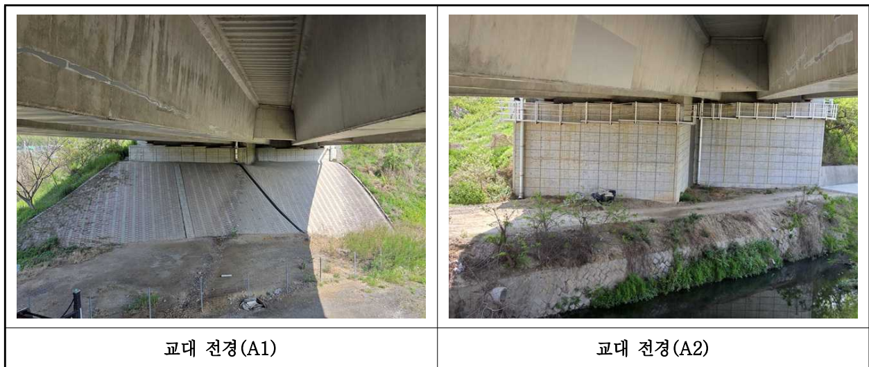
【사진 1.3.8】 교대 전경
